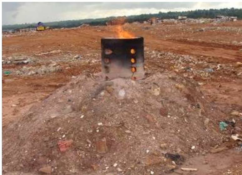
Um dos 24 queimadores de biogás em atividade no Aterro do Jôquei. Segundo técnicos do aterro, os queimadores queimam biogás 24 horas por dia, alguns por mais de três meses ininterruptos.
