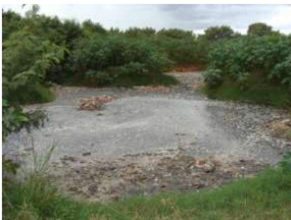
3ª lagoa de captação de chorume. Sem qualquer proteção contra infiltração no solo.
