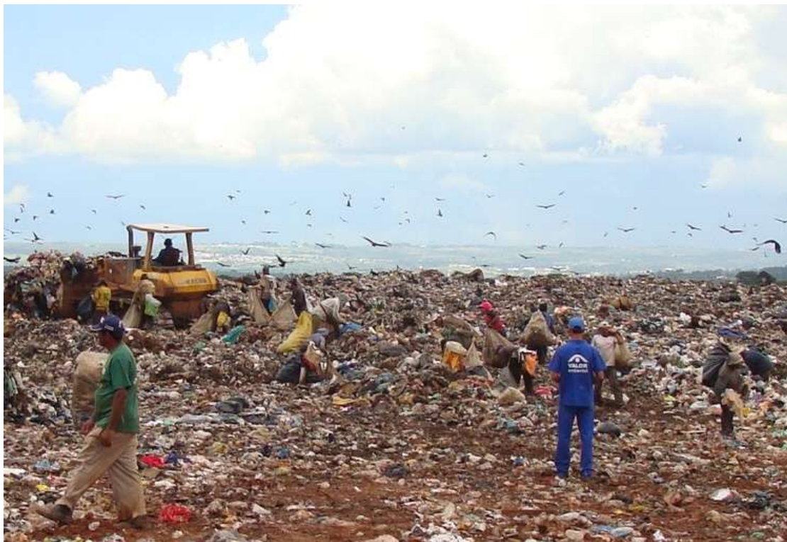
Foto do Aterro do Jóquei. Observa-se parte de uma vasta área de resíduos depositados sem cobertura, um trator de esteira espalhando e compactando os resíduos, grande quantidade de catadores no local e uma imensa quantidade de aves, a maioria urubus.
