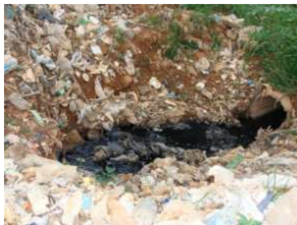
Chorume escoando para a lagoa de captação principal.
