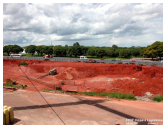
Foto 4 – Área destinada à construção dos auditórios.
