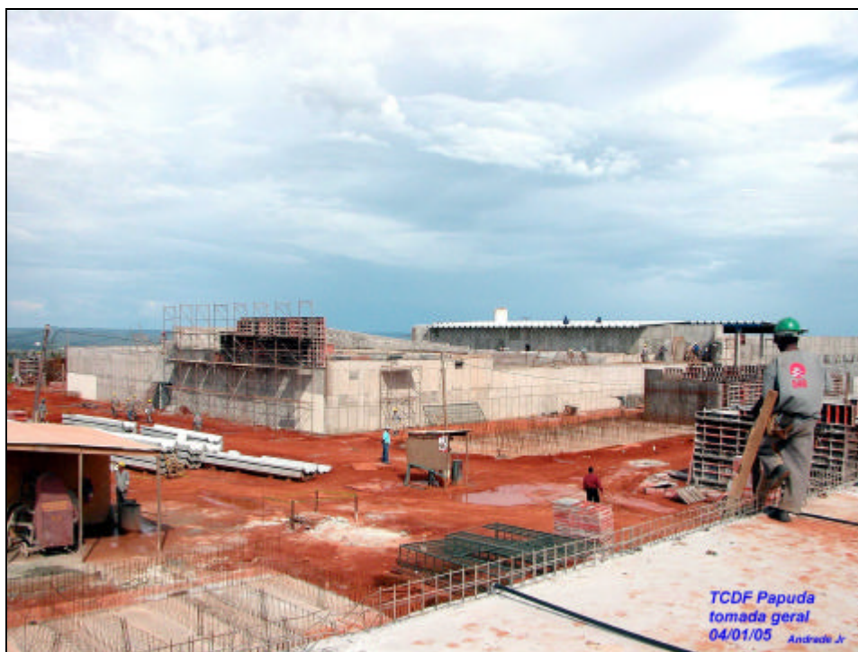
Foto 1 – blocos em construção
