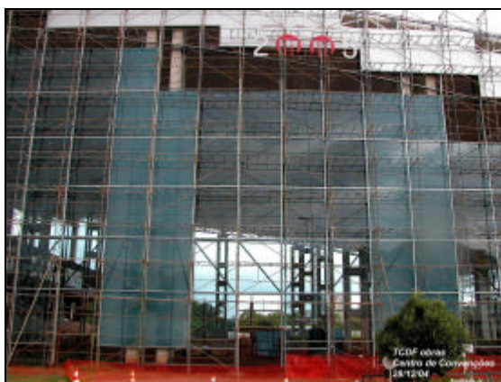
Foto 2 – Colocação dos vidros externos
