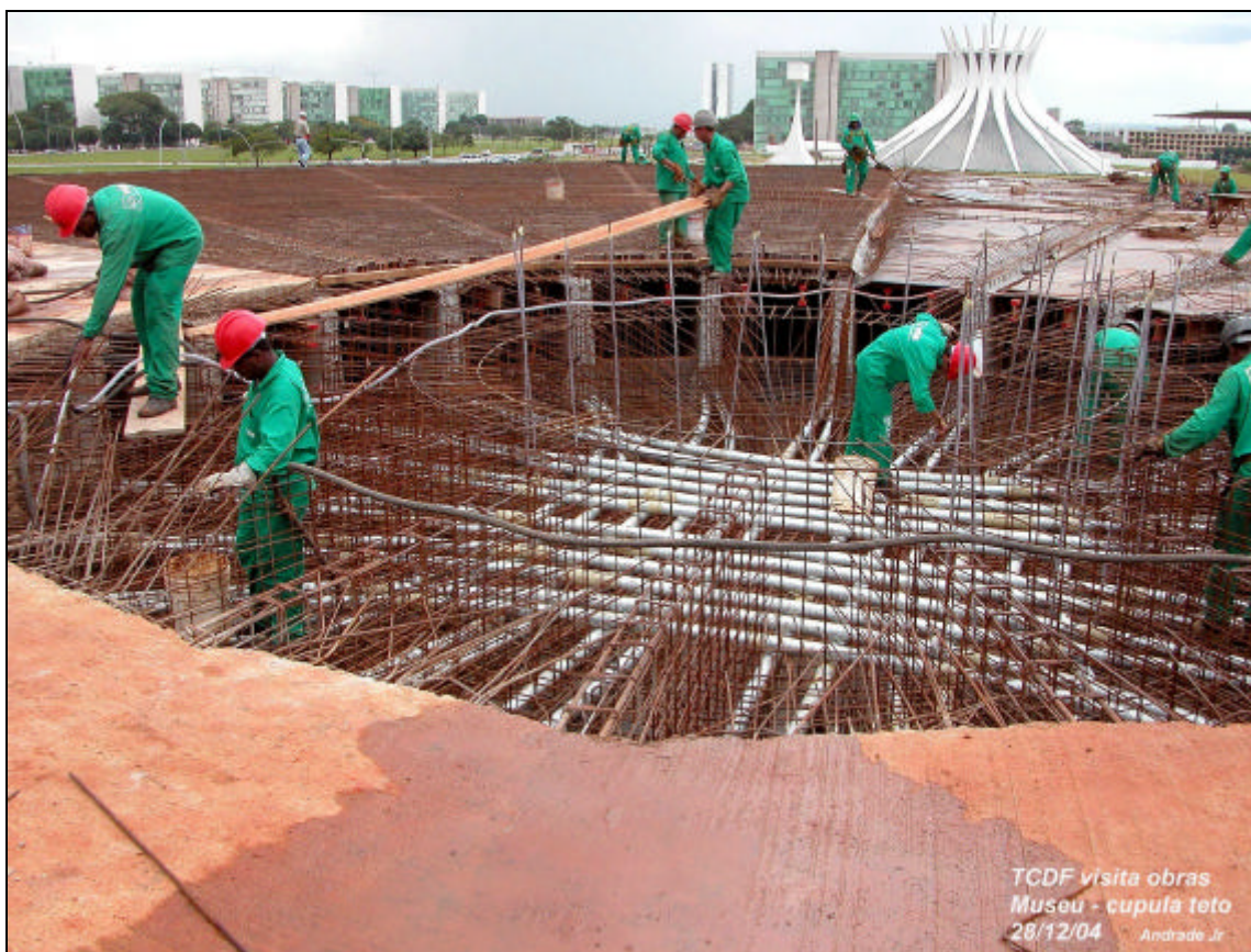
Foto 4 – Preparação para concretagem da lage
