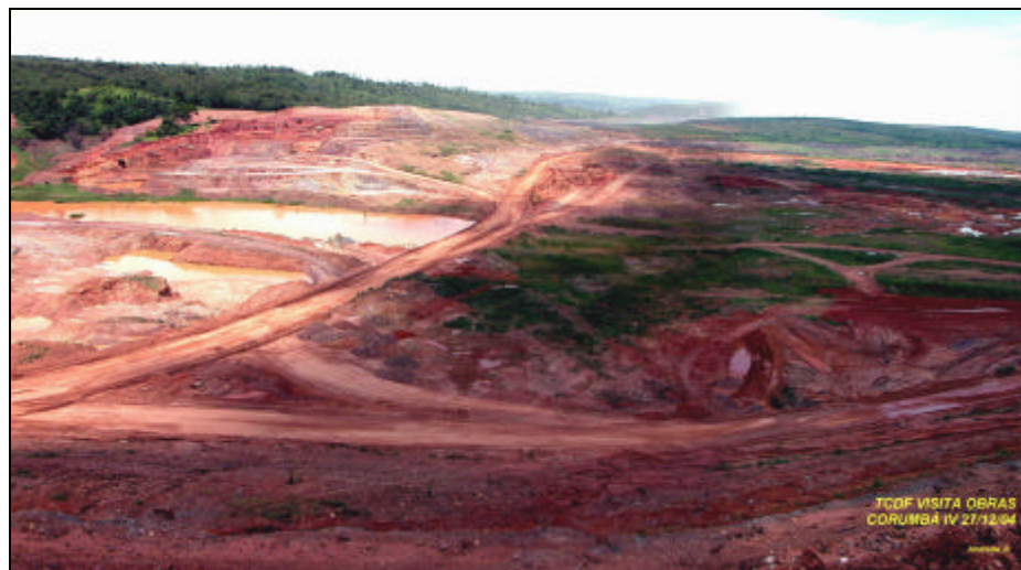
Foto 1 – Vista parcial da área a ser alagada pelo lago da barragem
