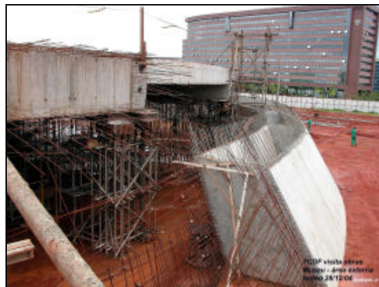
Foto 3 – Obras na área externa do Museu
