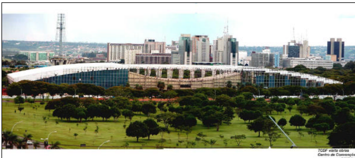
Foto 1 – Vista panorâmica do Centro de Convenções
