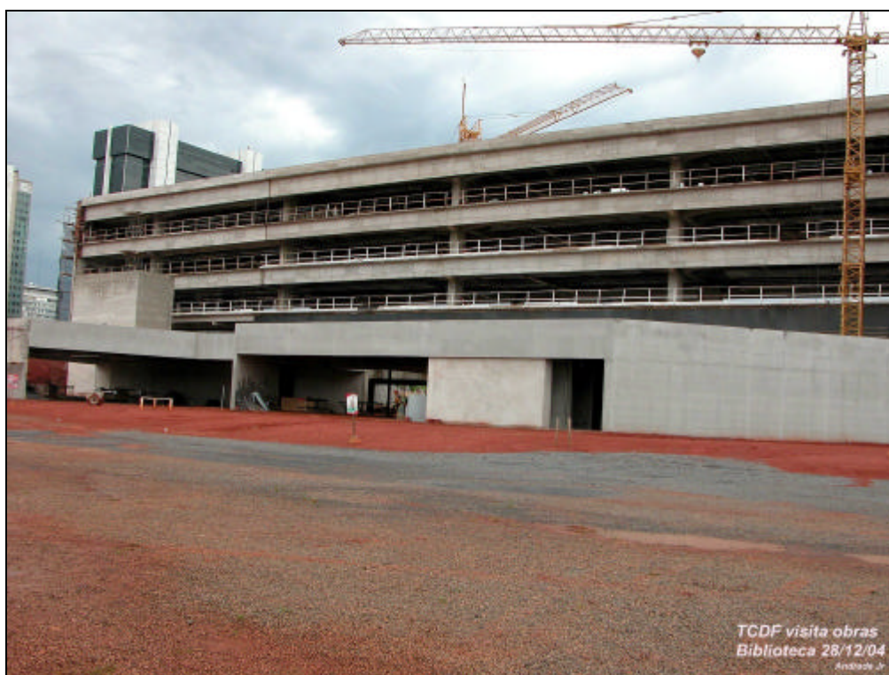
Foto 1 – Vista panorâmica da construção da Biblioteca
