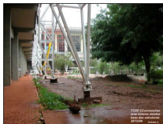
Foto 3 – Detalhe da sustentação das estruturas metálicas
