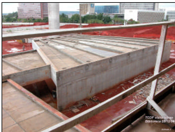
Foto 2 – Construção da Biblioteca
