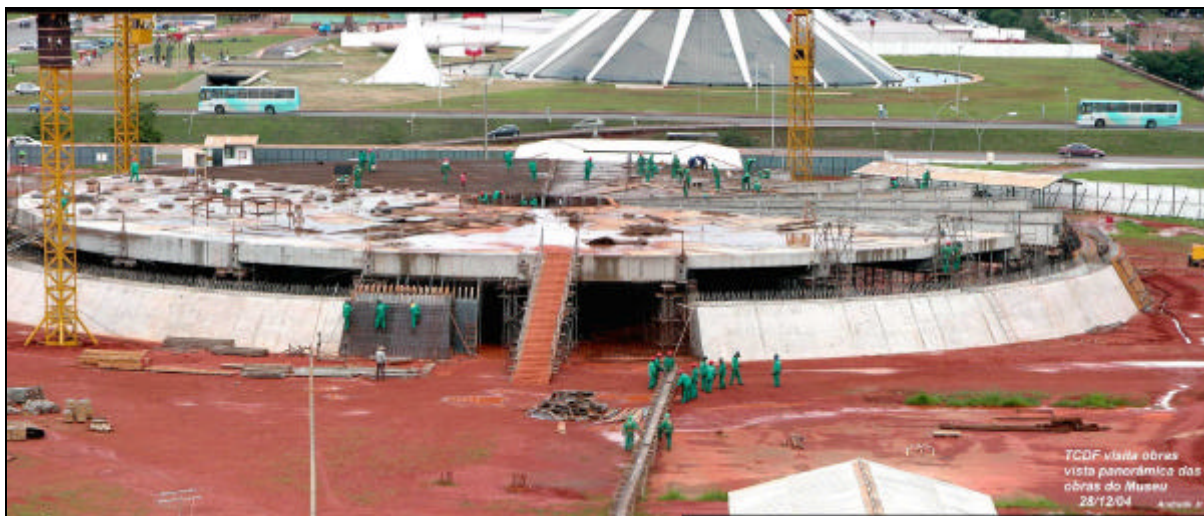
Foto 1 – Vista panorâmica do canteiro de obras do Museu
