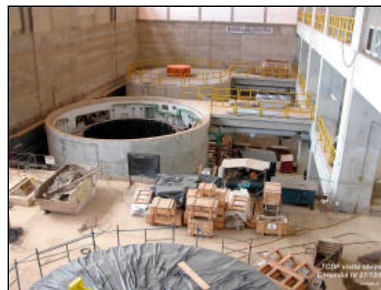
Foto 4 – Instalação das turbinas
