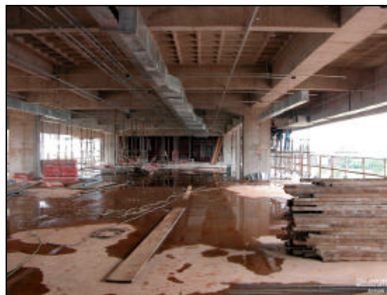
Foto 3 – Instalação da tubulação de ar condicionado
