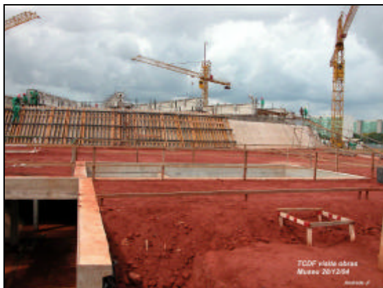
Foto 2 – Vista parcial das obras do Museu
