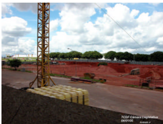
Foto 3 – Área reservada à construção do plenário.
